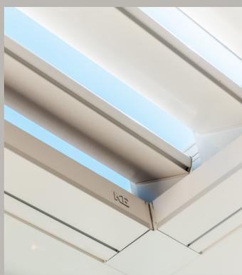
Un système de recueille de l'eau, gouttières pluviales, fait écouler l'eau à travers les colonnes. Les lamelles sont conçues pour permettre l'évacuation de l'eau à travers un bac de récupération intégré.
